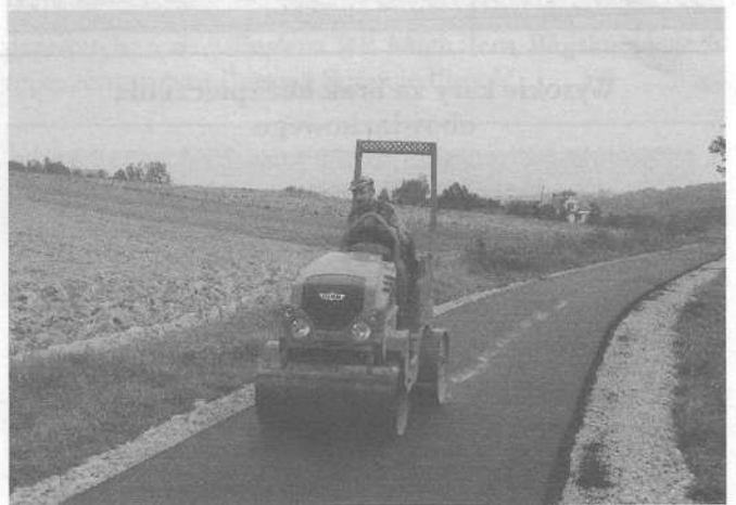
Budowa drogi na Przylaski
