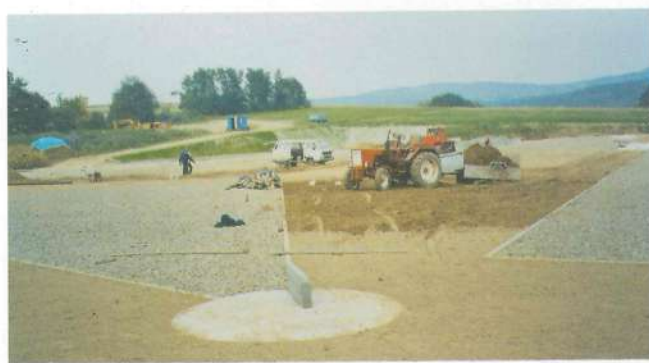
Rzutnia do pchnięcia kulą
