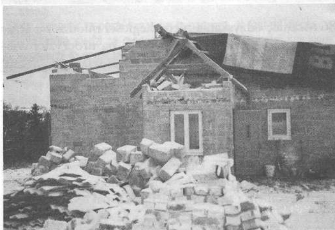
Huragan, który przeszedł nad naszą gminą 7 października wyrządził wiele szkód i zniszczeń. Na zdjęciu zniszczony dom w Rzepienniku Strzyzewskim.
