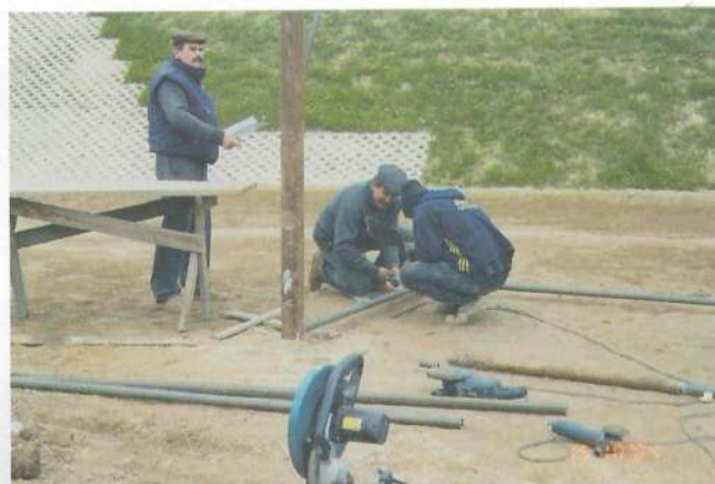
Montaż bramek pod nadzorem Kazimierza Górskiego
