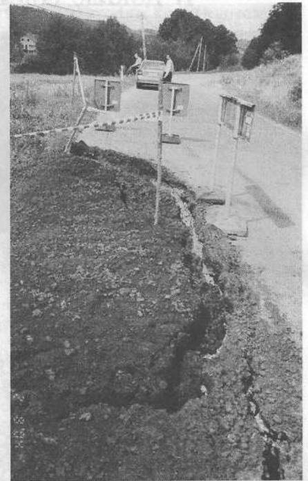
29 lipca br. wylata Rzepianka, powodując wiele szkód. Zniszczyła mostki, przepusty, drogi.
