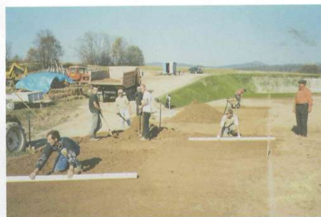
Ostatni etap budowy
