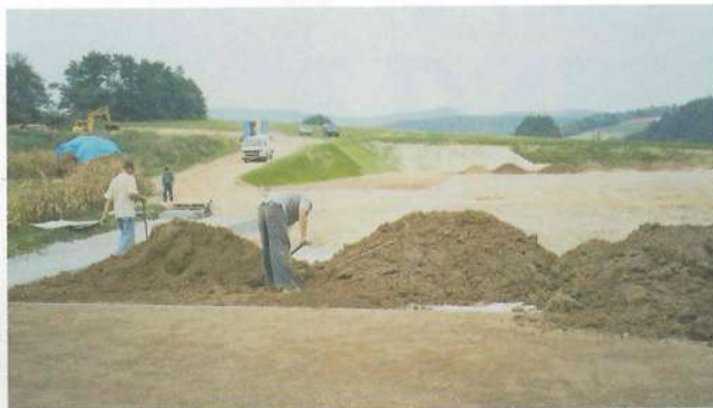
Rozrównywanie humusu na geowłókninę
