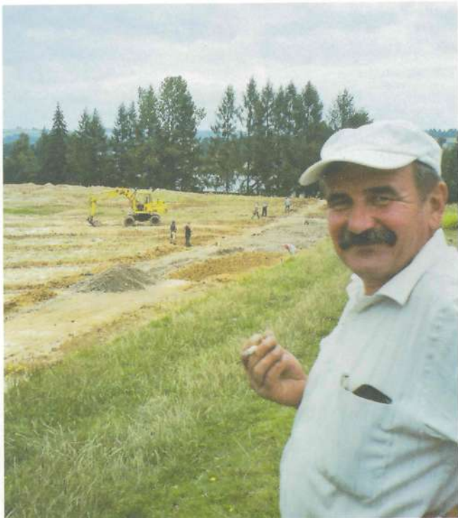
Meliorację i zasypywanie sączków drenarskich nadzoruje Janusz Prokop
