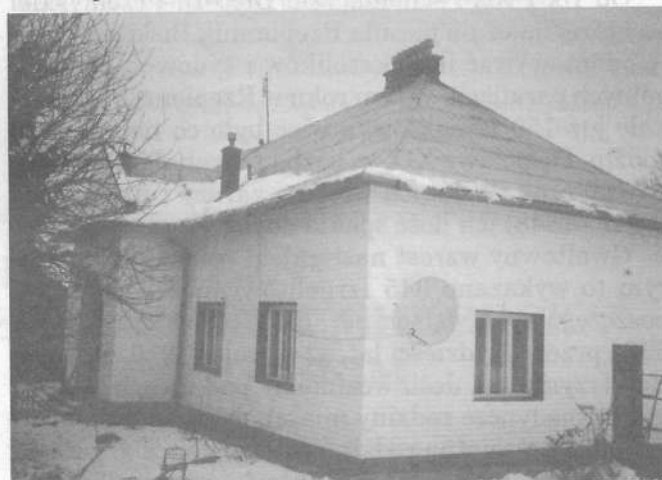
Nową elewację zyskało Przedszkole Publiczne w Rzepienniku Biskupim.
