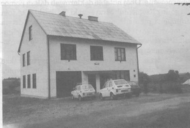
Tak prezentuje się nowa remiza w Kolkówce, w której mieści się również sklep
