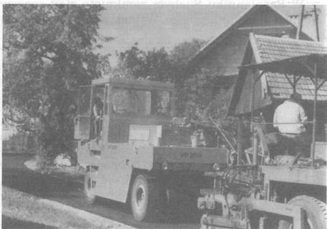
Asfaltowanie drogi w Rzepienniku Suchym
