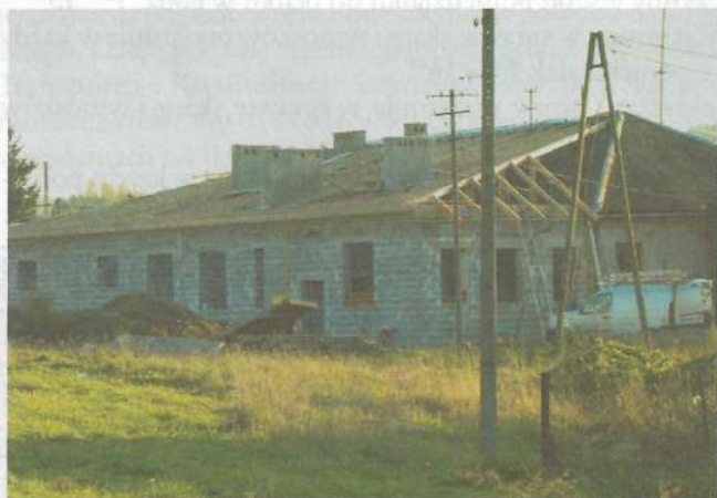
Rozbudowa piekarni Gminnej Spółdzielni „SCh” w Rzeczywiście Strzyżewskim
