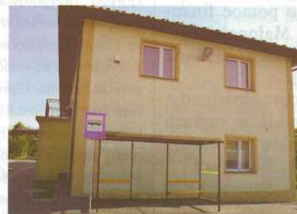
Nowy estetyczny przystanek autobusowy przy budynku GOK w Rzepienniku Suchym
