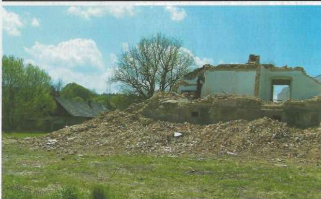
Rozbiórka dworu szlacheckiego w Olszynach
