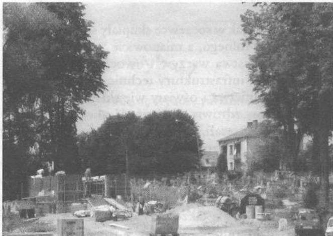
Budowa kaplicy cmentarnej w Turzy
