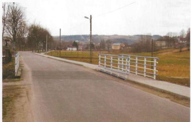
Most przy szkole w Olszynach wraz z budową kładki zmodernizowano za ponad 60,000 tys. zł.
