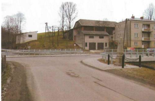
Wyremontowany w 2008 r. most w centrum Olszyn kosztował ponad 800.000 tys. zł
