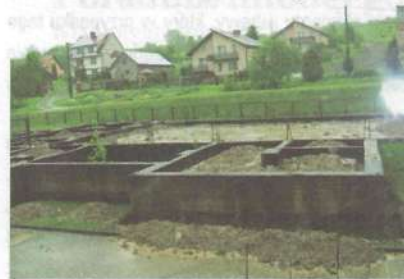
Fundamenty pod salę widowiskową
