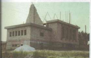
Budowa kościoła w Rzepienniku Suchym
